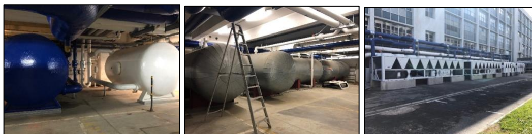
Fase II-installasie van die sentrale HVAC-stelsel op Tygerbergkampus (van links): die sentrale koelaanleg, buffertenks en wateropgaartenks.
